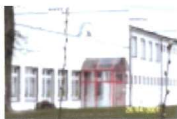
Budynek Szkoły Podstawowej
